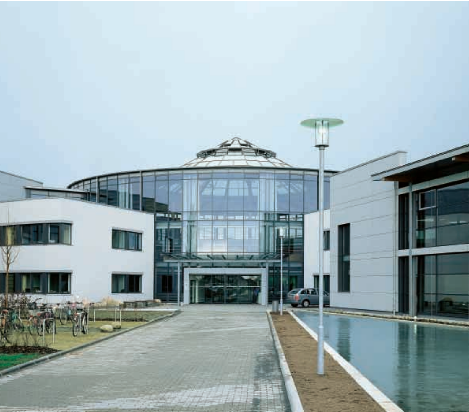
Park-Krankenhaus Psychiatrische Kliniken Neubau
