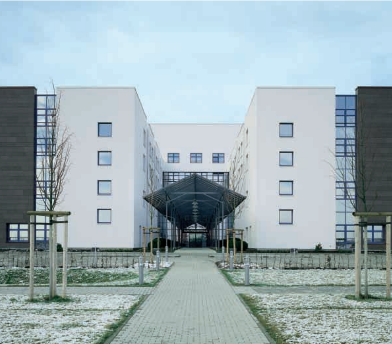
Park-Krankenhaus Somatische Klinik Neubau
